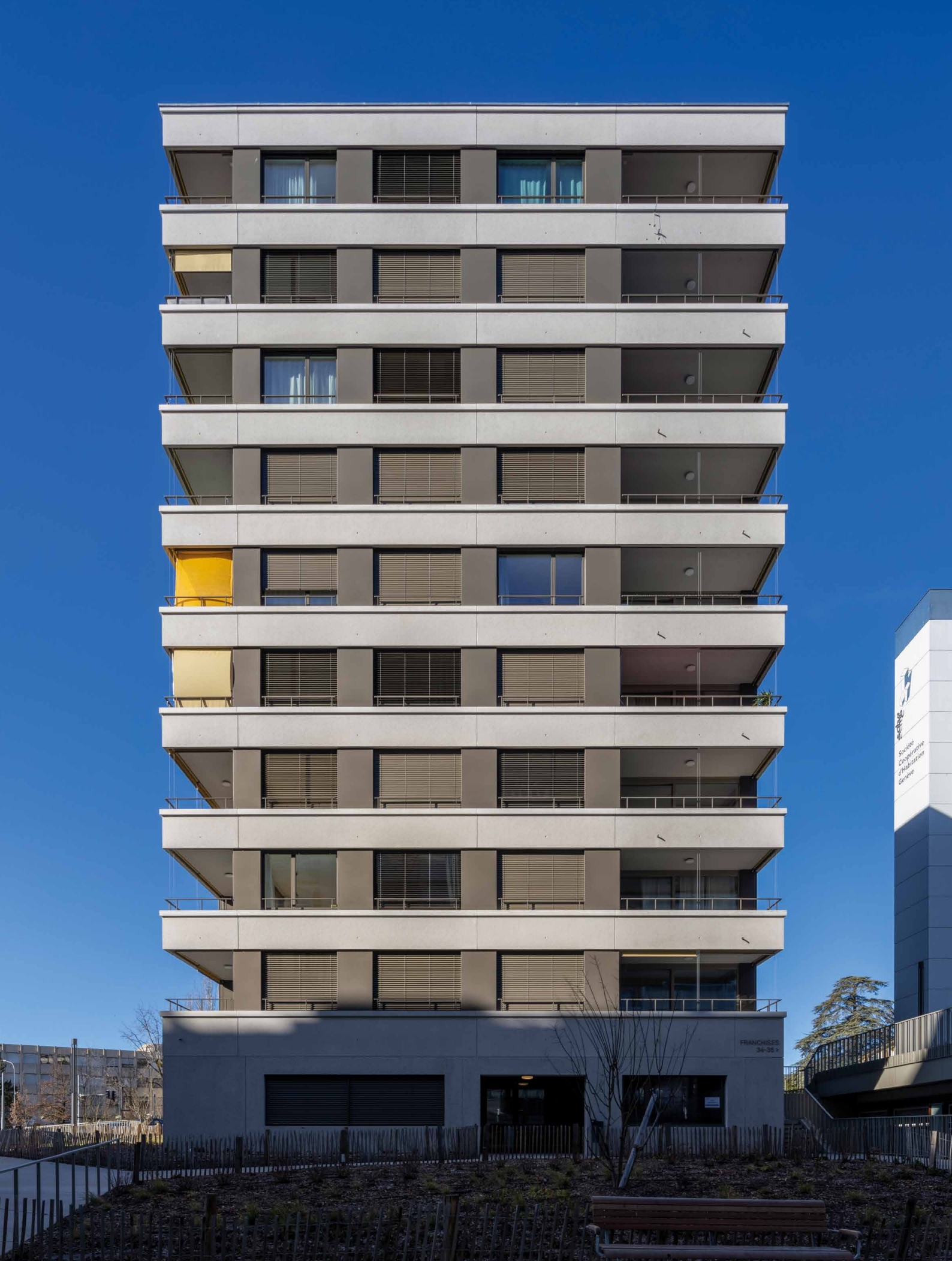
FAÇADE DE L'IMMEUBLE LOUISA-VUILLE 6-8
